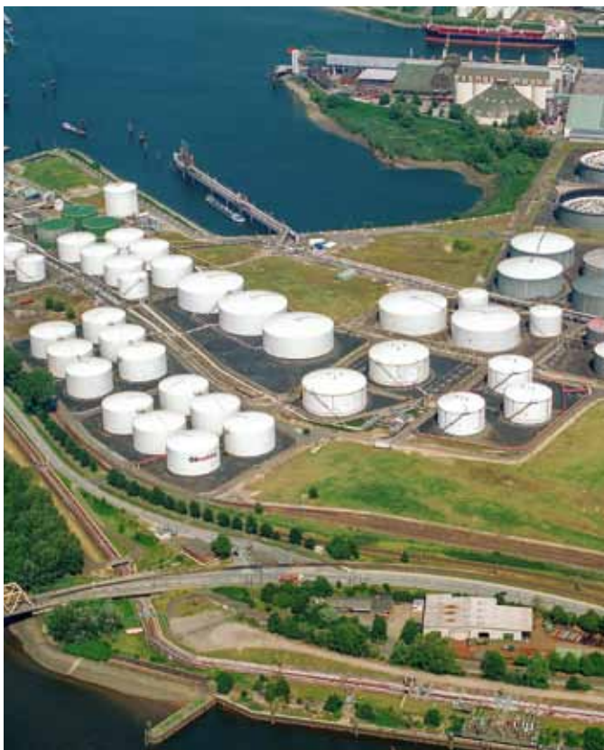
Rückverflüssigungsanlage von Oiltanking Deutschland.
