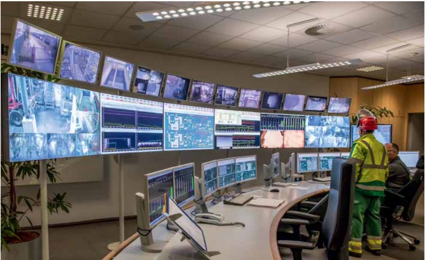
Die hochtechnisierte Schaltwarte ist das Hirn der Verbrennungsanlage. Eine Batterie von Bildschirmen sorgt dafür, dass jeder Schritt während des Entsorgungsprozesses beobachtet und kontrolliert werden kann. Über die Monitore hat man auch den direkten Blick in die beiden Verbrennungsöfen.
