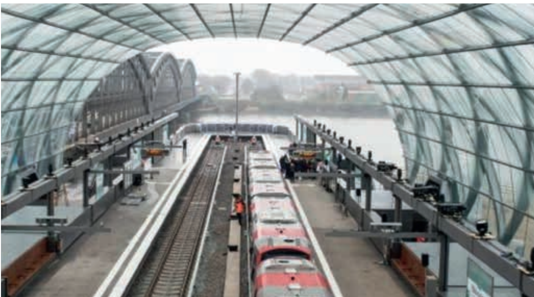
Mobilität für die Zukunft: Mit der neuen U-Bahn-Station Elbbrücken ist die Hafencity nun auch im Osten an das Hamburger Schnellbahnsystem angeschlossen.
