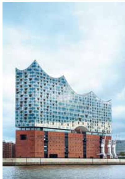
Hamburgs Wahrzeichen ist auch im Innern hochmodern ausgestattet.
